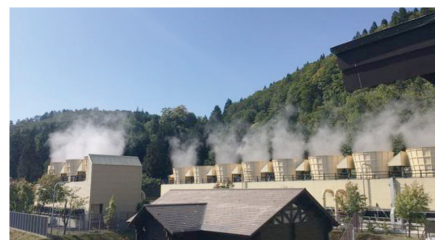
上の岱地熱発電所(秋田県湯沢市) 出典：資源エネルギー庁HP「エネこれ」 地熱エネルギーの宝庫・東北エリアで見る、地熱発電の現場(前編)より
