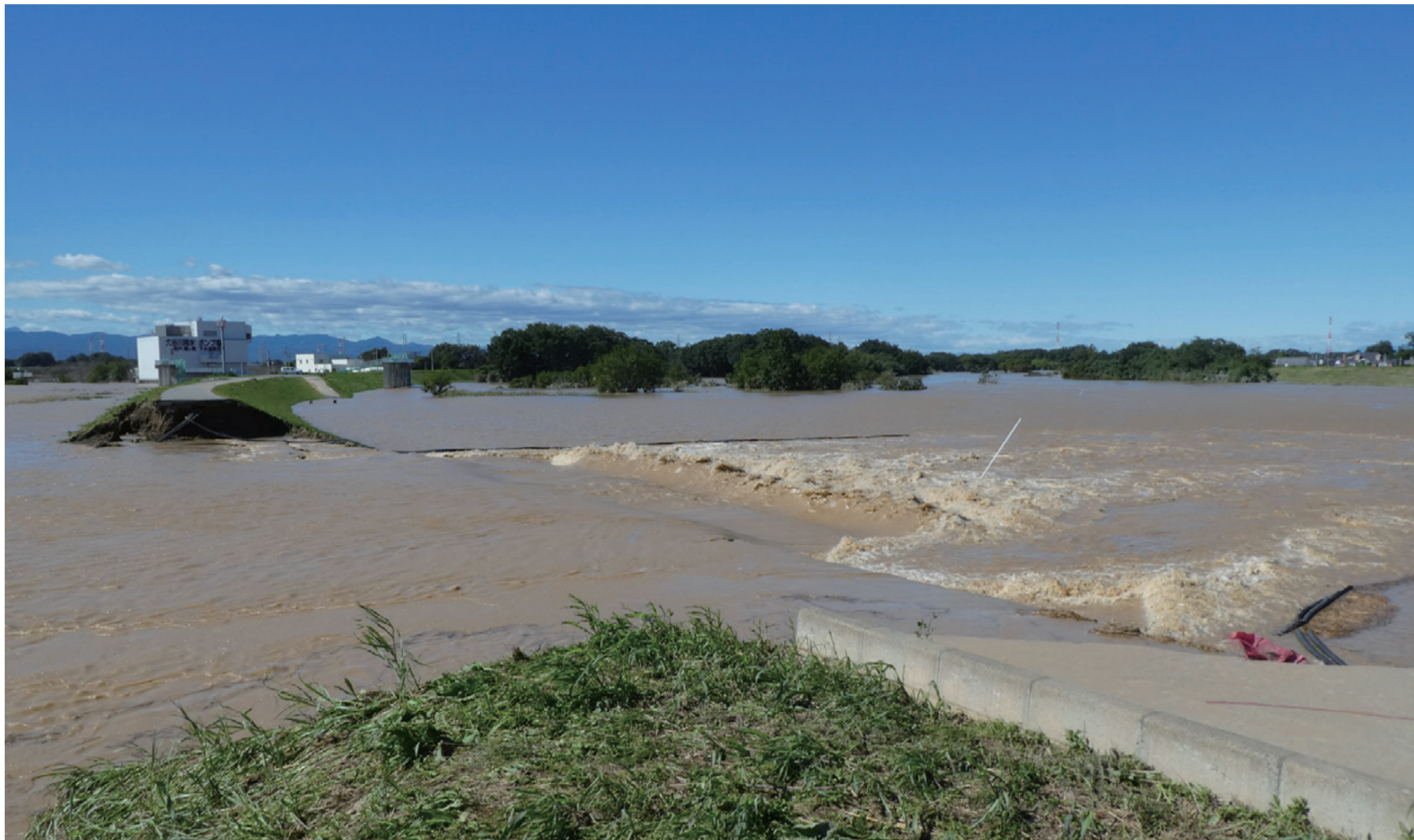
2019年 台風19号で堤防が決壊した越辺川(埼玉県)
