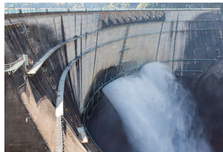
水力発電所（富山県立山町）
