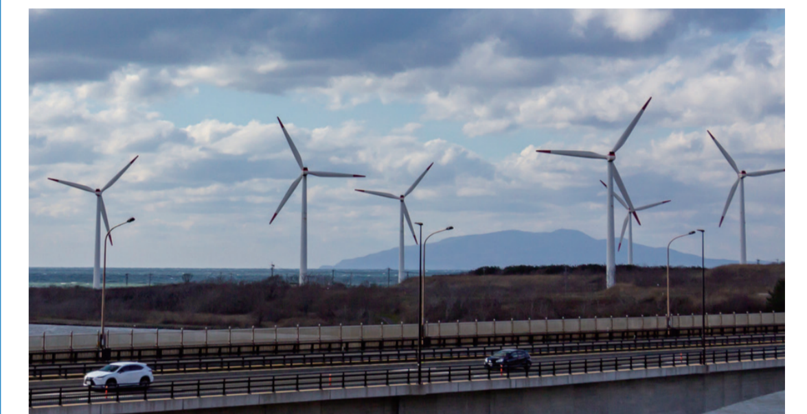
海岸沿いの風力発電所 (秋田県)
